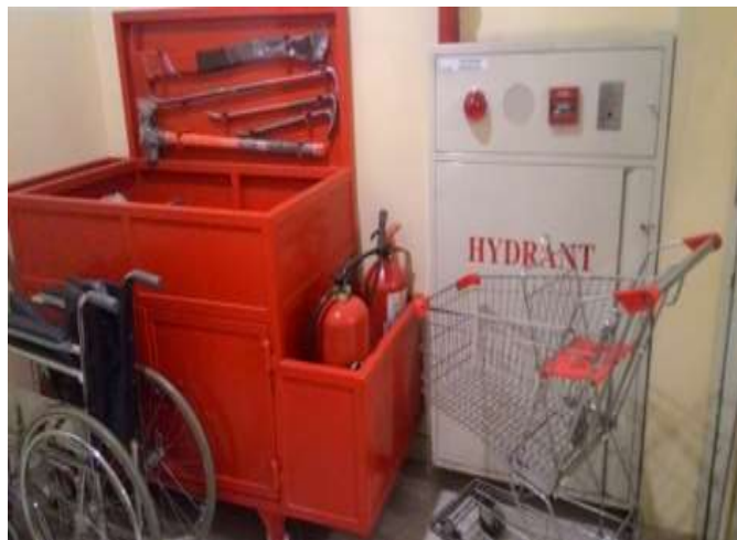
Gambar 4.9 Troli dan Fire Troli menghalangi hidrant
