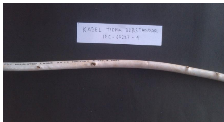
Gambar 4.4 Kabel Tidak Berstandar IEC 60227 – 4 Setelah Dialiri Arus 76 Ampere
