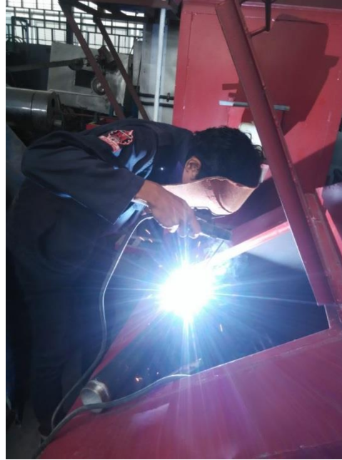
Gambar 1. Proses pengelasan pada bodi tungku alat desalinasi.
