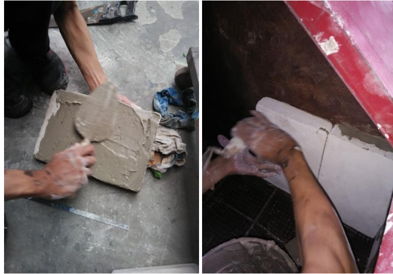
Gambar 3.26. Proses pemasangan bata ringan pada dinding tungku
