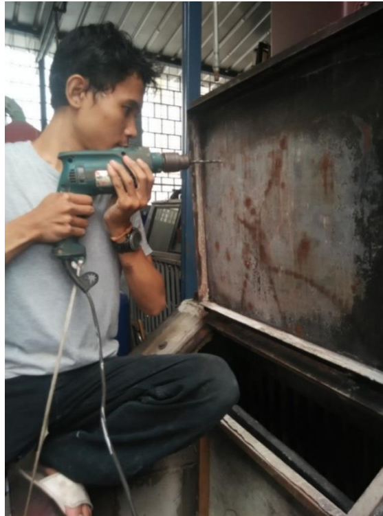
Gambar 3.2. Proses Pengeboran Menggunakan Mesin Bor Tangan
