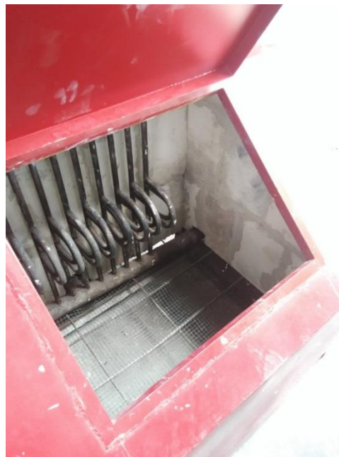
Gambar 9. Hasil pemasangan bata ringan pada sisi dalam tungku alat desalinasi
