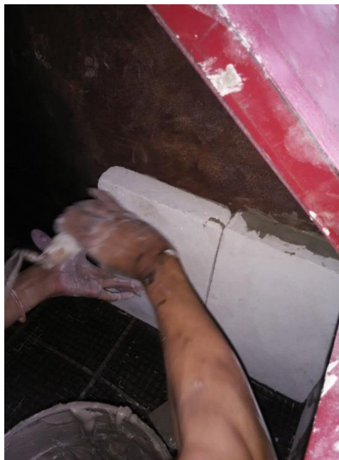
Gambar 6. Proses Pemasangan bata ringan pada bodi sisi dalam tungku alat desalinasi
