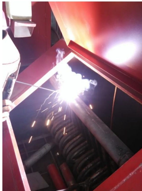
Gambar 2. Proses pengelasan pada pipa heater
