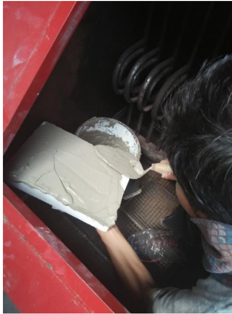
Gambar 5. Proses pelapisan bata ringan dengan semen mortar
