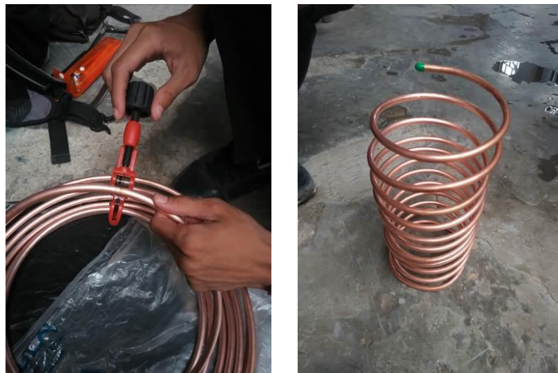
Gambar 3.28. Proses pemotongan dan spiral pipa kondensasi
