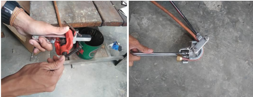
Gambar 3.27. Proses Flaring dan pembengkokan pipa kondensasi
