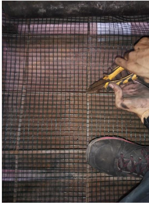
Gambar 3. Proses pemasangan jaring penyangga bahan bakar pada tungku alat desalinasi
