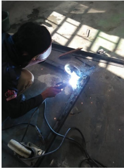
Gambar 8. Proses pembuatan alas roda tungku alat desalinasi
