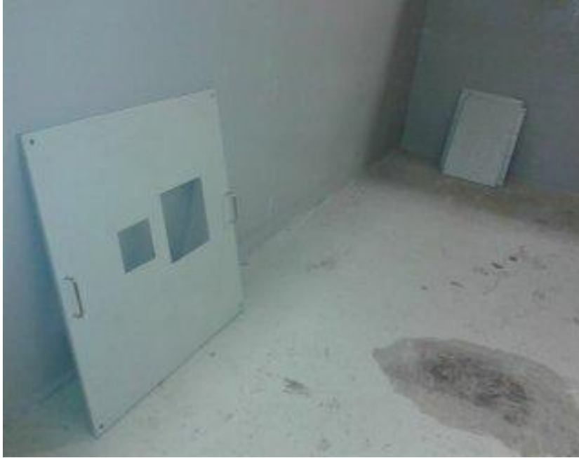
Gambar 4.23. Cover Panel yang Terletak di Lantai
