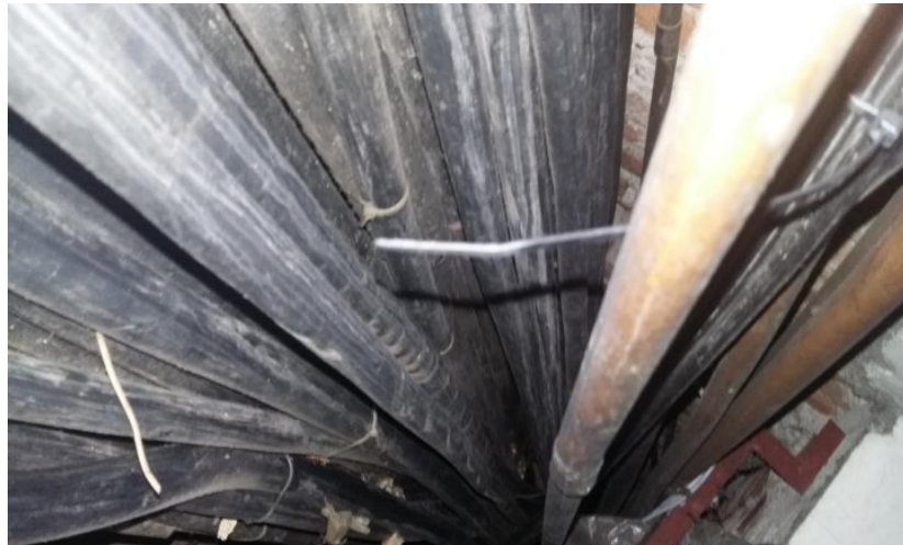
Gambar 4.10 Bukaan Vertikal Kabel
