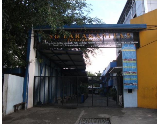
Gambar 1: Tampak depan SD Tarakanita 5 Rawamangun (CD 1)
