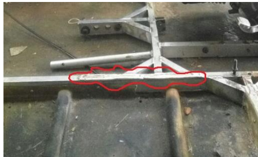
Gambar 1.2 Perbaikan Akibat Crack
