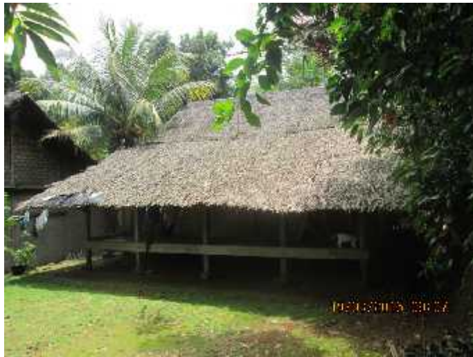
Gambar 4.13 dokumentasi bentuk rumah di kampung Campaka, Baduy Luar, 19 Maret 2016
