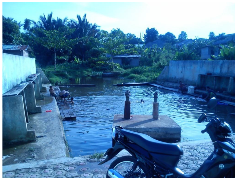
Gambar 4. Foto masuknya lokasi permandian Desa Air Tua Tunu
