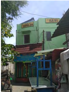
(Gambar 20. Gedung SLB BC Cempaka Putih)
