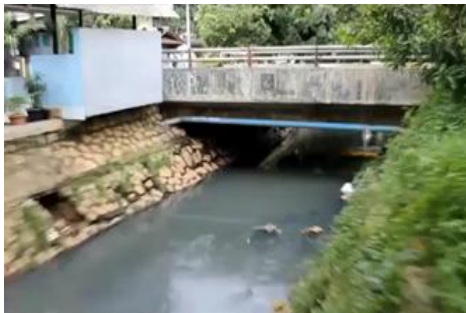
Gambar 1.3 Saluran Eksisting kali Rawa Lumbu di Perumahan Bumi Bekasi Baru
