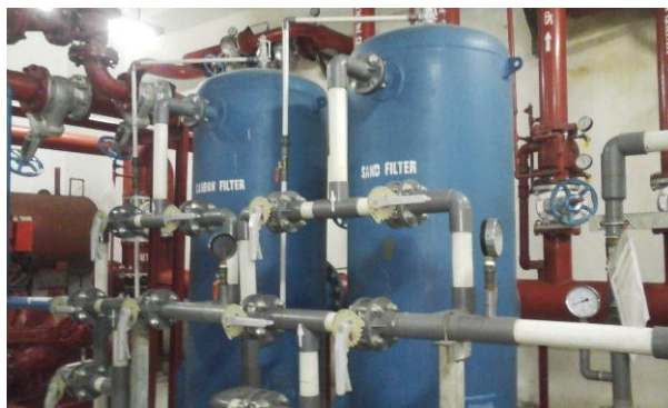
Sumber : Kementerian Pekerjaan Umum, 2016
