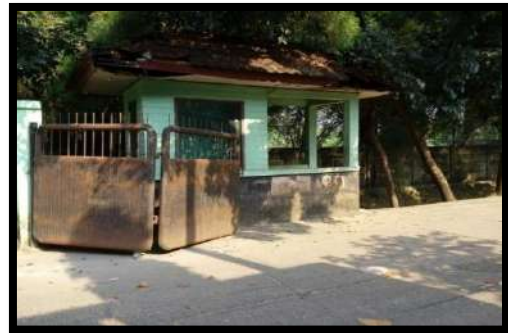
Gambar 4.2 Pos Satpam TPST Sumur Batu, Bantar Gebang, Bekasi (CD.1 , Gbr.4)
