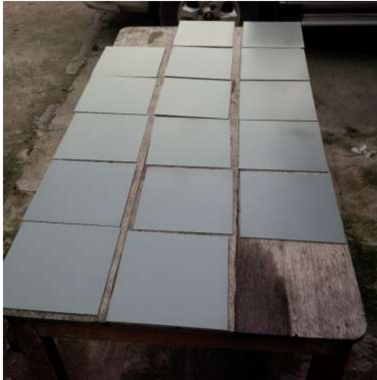
3. Proses Pengeringan Setelah Diaplikasi Epoxy Primer
