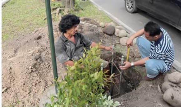
Gambar 2.18 Pemasangan Lampu Taman pada Proses Pembuatan Taman
