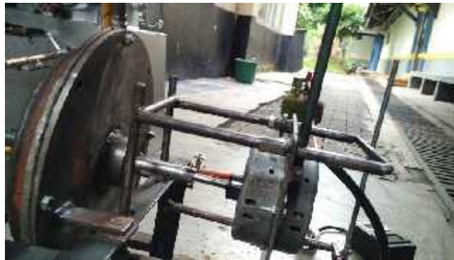
Gambar 4.6. Pemasangan Generator Dengan Turbin
