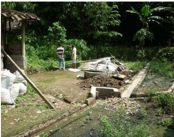
Foto 7. Saluran pemasukan (inlet) biodigester yang berasal dari tiga kandang, sehingga alat ini dapat menjadi solusi bagi peternak sapi perah dalam membuang limbah kotoran sapi tanpa mencemari lingkungan di sekitarnya.
