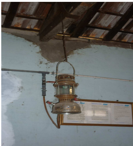
Foto 3. Biogas juga dapat digunakan pada petromak yang sering difungsikan pada saat mati listrik
