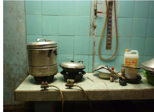
Foto 2. Pemanfaatan biogas pada kompor khusus biogas. Manometer dibuat dekat dengan kompor, dengan tujuan agar responden mengetahui besarnya tekanan gas yang akan digunakan dalam aktivitas memasak
