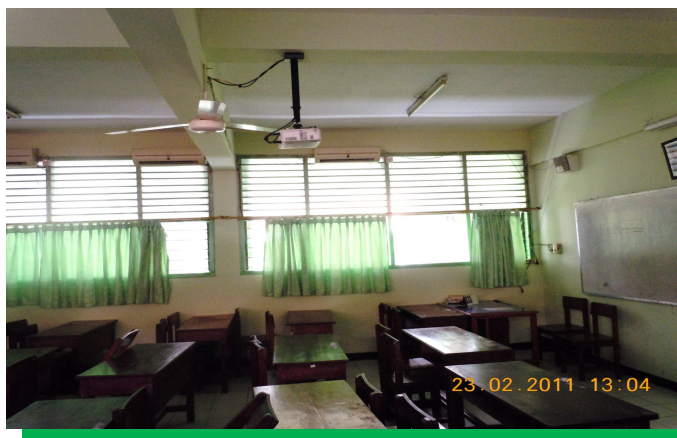
Kondisi ruang kelas XI Alam SMA N 70 Jakarta
