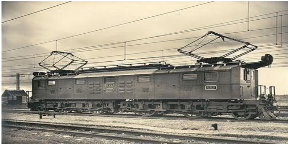
Gb. 5. Lokomotif Listrik ESS 3201.
