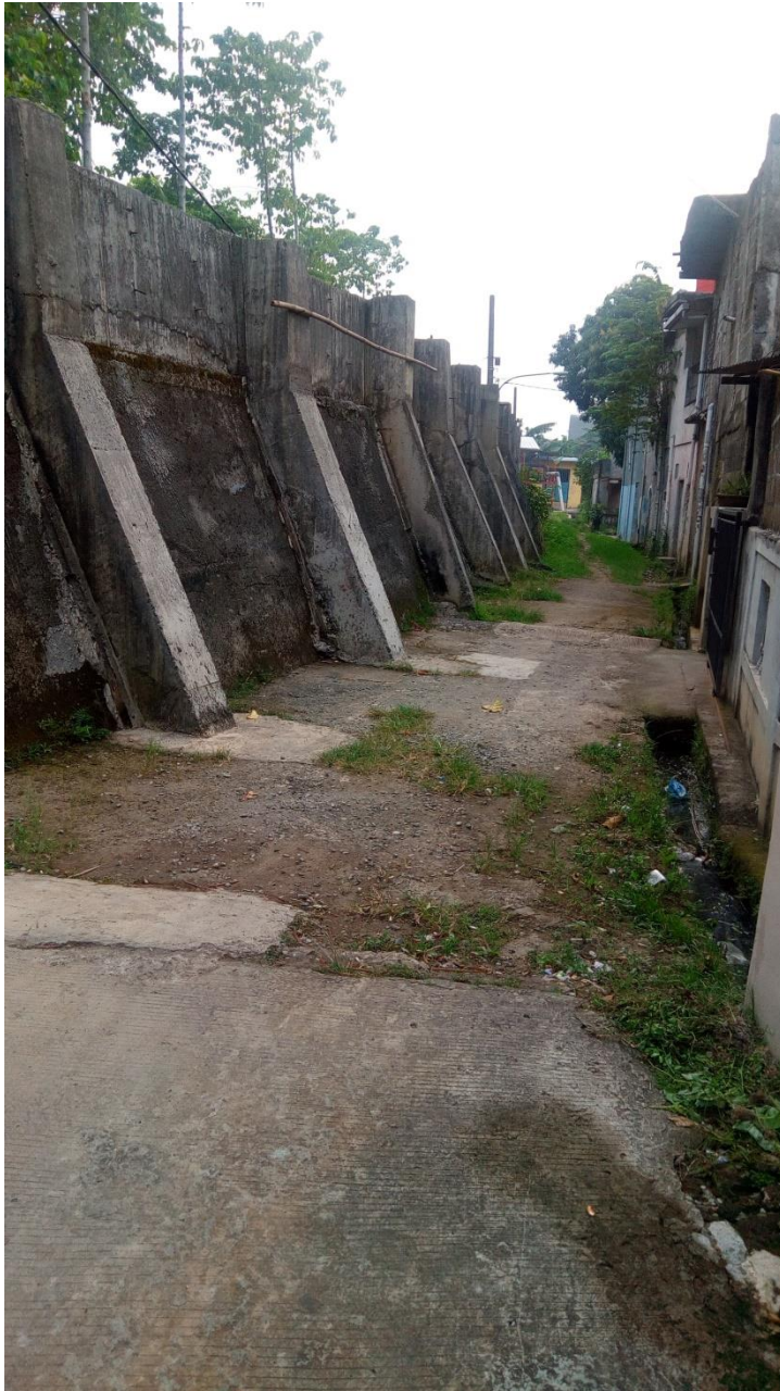
Gambar Tanggul Pada Perumahan Pondok Gede Permai
