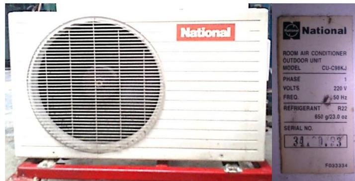
**Gambar 3.3.** Unit *Outdor AC* dan Spesifikasinya
