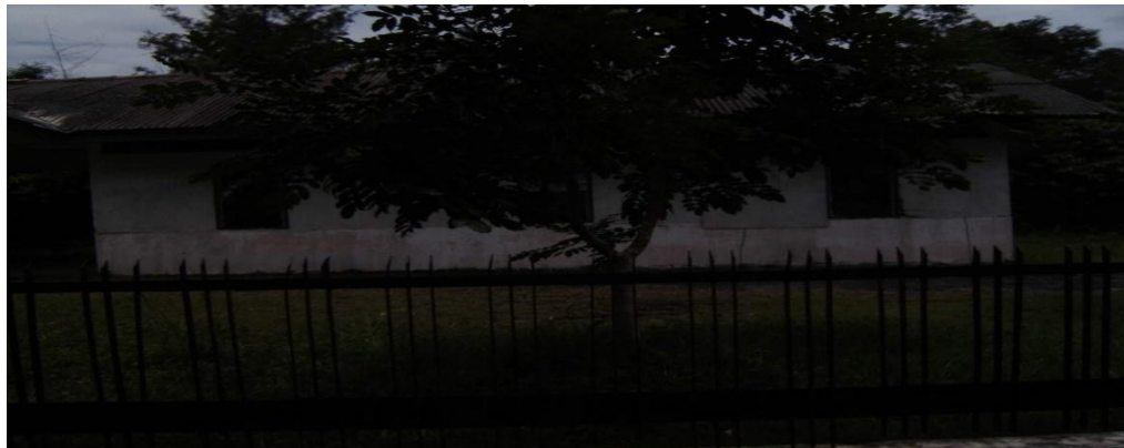
Gambar III.2 Rumah Penampungan PMB Batam
