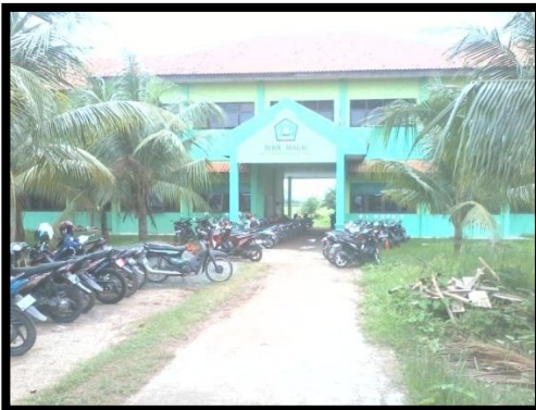
PINTU MASUK KAMPUS 2
