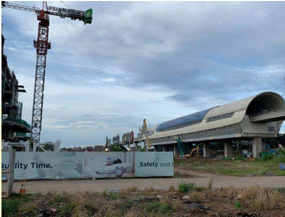
Gambar 1 Kondisi Stasiun LRT Ciracas (Diambil pada tanggal 21 Desember 2020)
