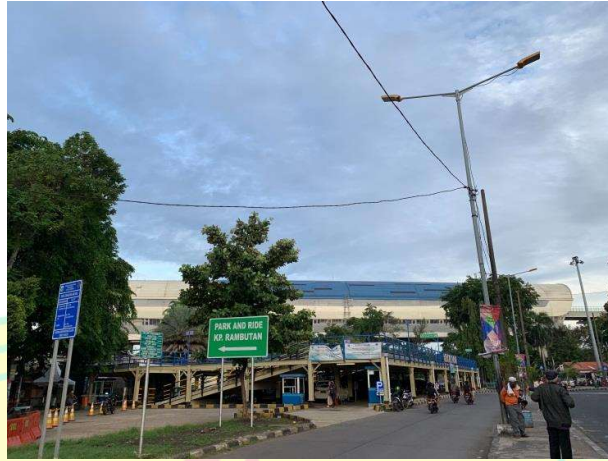
Gambar 2 Kondisi Stasiun LRT Kampung Rambutan (Diambil pada tanggal 21 Desember 2020)
