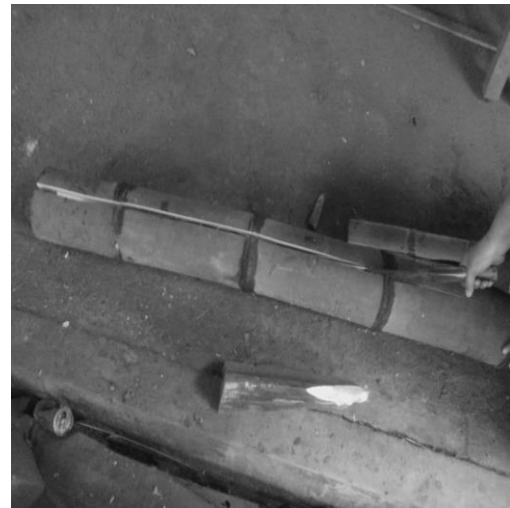
Gambar 3.12 Pembelahan bambu dengan golok
