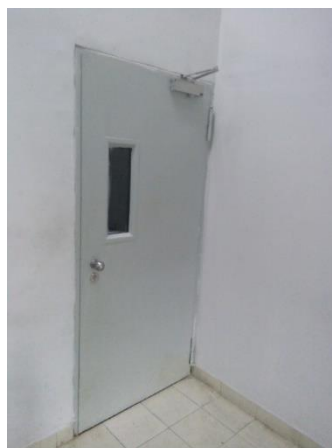
Gambar 4.48 Pintu Darurat Arah Barat Tampak Belakang
