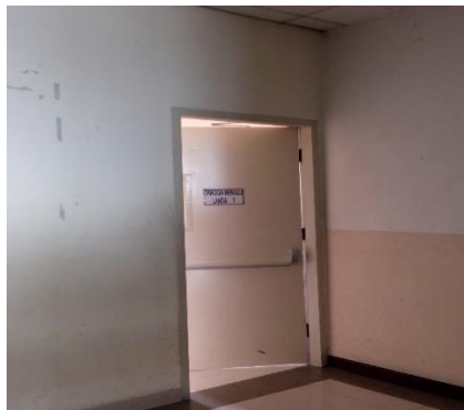
Gambar 4.60 Pintu Darurat Gedung Ki Hajar Dewantara
