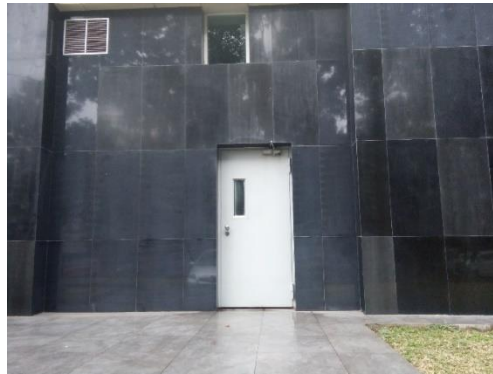
Gambar 4.57 Pintu Darurat Arah Timur dari Luar Bangunan
