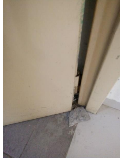
Gambar 4.9 Pintu Darurat Ditahan Menggunakan Batu
