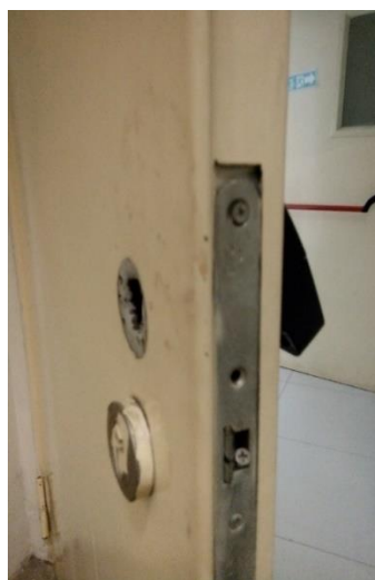
Gambar 4.31 lockcase yang ditahan oleh baut
