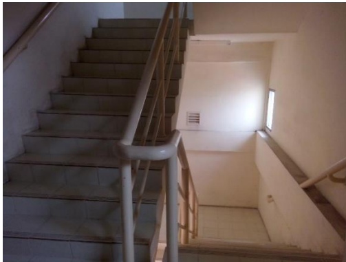
Gambar 4.62 Tangga Darurat Gedung Ki Hajar Dewantara
