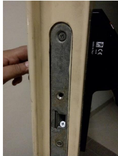
Gambar 4.11 Lockcase Pintu Ditahan Menggunakan Baut
