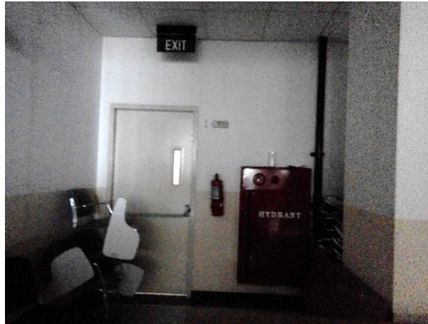
Gambar 1.1 Sarana Jalan Keluar Gd. Ki Hajar Dewantara UNJ
