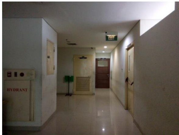
Gambar 4.20 Tanda Exit Menuju Pintu Darurat Arah Barat
