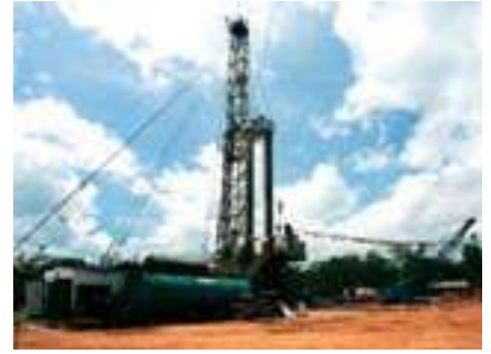
Onshore Rig (Gelam TAC)
