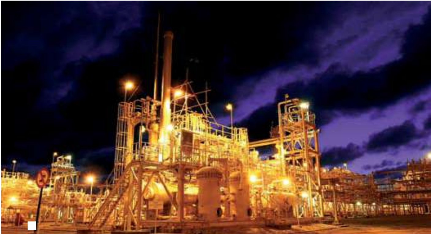
Pagerungan Gas Processing Facilities (Kangean PSC)
