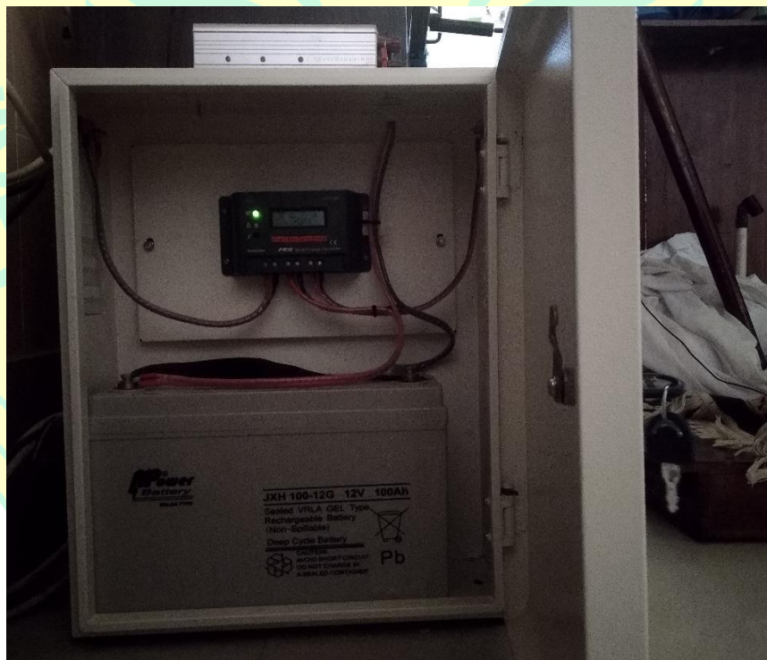
Kotak Berisi Baterie, Solar Charge Controller , dan Inverter
