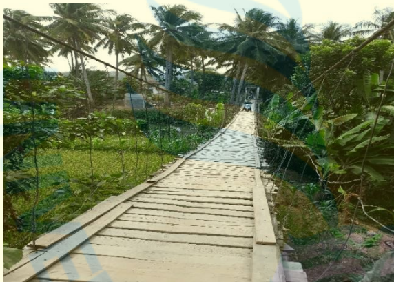
Gambar 3. Jembatan di Desa Sawarna
