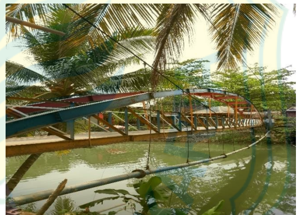
Gambar 4. Jembatan di Desa Sawarna
