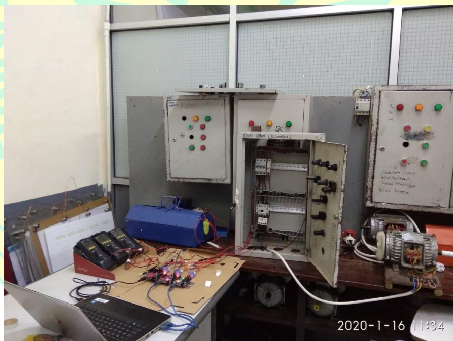
Gambar 10. Monitoring Suplai Tegangan pada Motor Induksi Tiga Fasa Secara Keseluruhan
