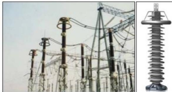
**Gambar 2.30 *Lightning Arrester* (LA)**
