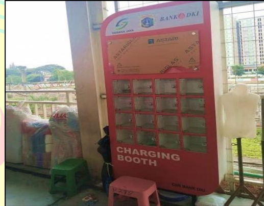
Foto 2. Fasilitas Charging Booth di Jembatan Penyeberangan Multiguna Tanah Abang
