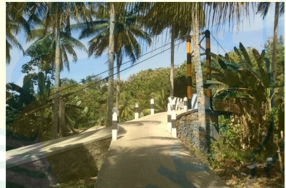
Foto 4. Jembatan menuju Pantai Legon Pari
