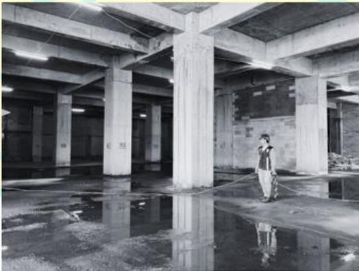
Gambar 1.1 Genangan air di sekitar kabel
