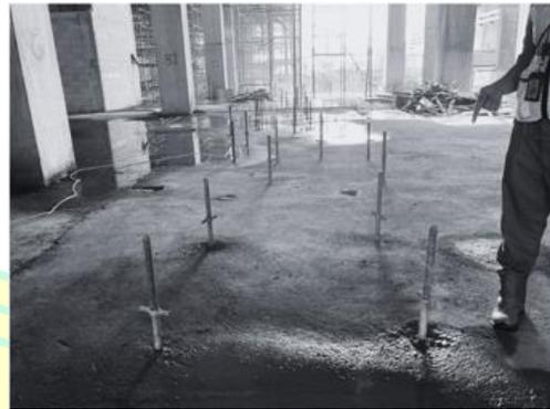
Gambar 1.4 Tersisa besi pra pengecoran yang belum terpotong
