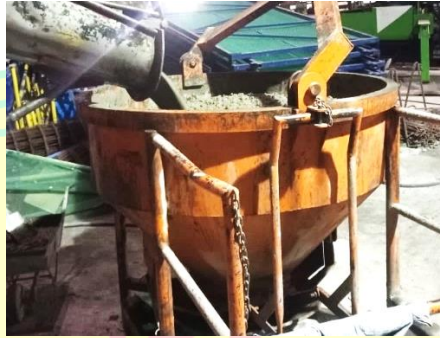
(Sumber: Dokumentasi Kelompok di Proyek Menara BRI Gatot Subroto) Gambar 2.6 Concrete Bucket
