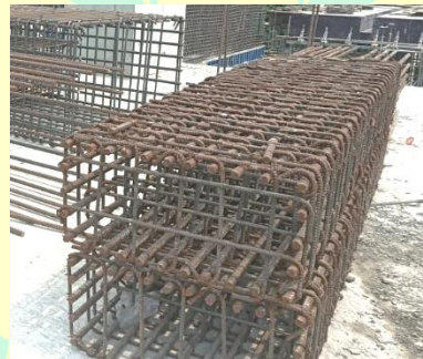
Gambar 2.1 Kolom dengan Tulangan Sengkang Persegi
