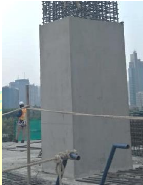
Gambar 2.2 Kolom dengan Tulangan Senggang Persegi Setelah Dilakukan Pengecoran
