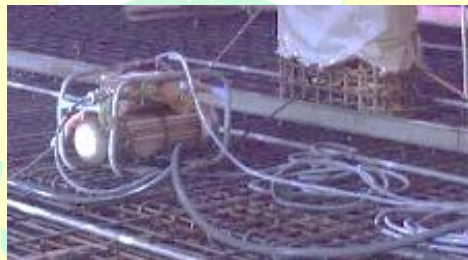
(Sumber: Dokumentasi Kelompok di Proyek Menara BRI Gatot Subroto) Gambar 2.7 Concrete Vibrator
