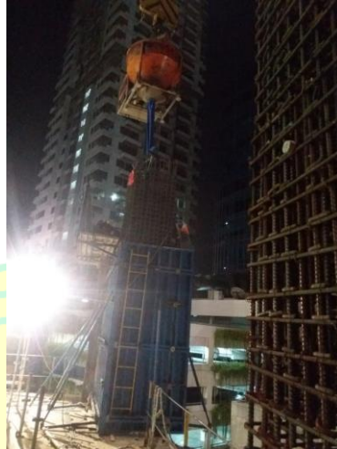
Gambar 4.22 Pengecoran dan Pematatan
