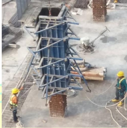
Gambar 4.15 Instalasi Bekisting Kolom
