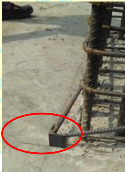
Gambar 4.13 Pemasangan Sepatu Kolom
