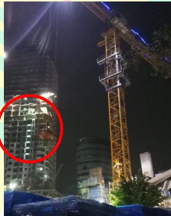
Gambar 4.21 Pengangkutan Bucket Dengan Tower Crane
