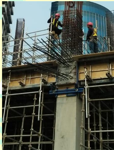
(Sumber: Dokumentasi Kelompok di Proyek Menara BRI Gatot Subroto) Gambar 4.4 Kepala Kolom
