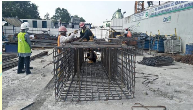
Gambar 4.10 Perakitan Tulangan Kolom
