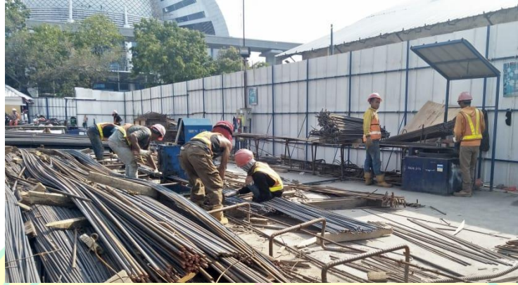
Gambar 4.8 Pemotongan Tulangan Kolom
