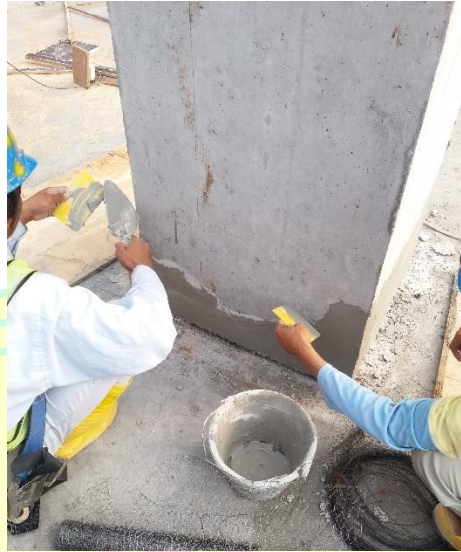
Gambar 4.25 Pekerjaan Perbaikan Kolom
