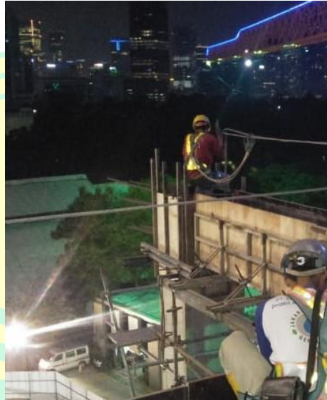
Gambar 4.3 Perakitan Bekisting Kepala Kolom
