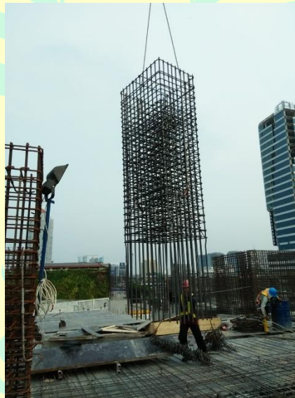
(Sumber: Dokumentasi Kelompok di Proyek Menara BRI Gatot Subroto) Gambar 4.11 Pemasangan Tulangan Kolom
