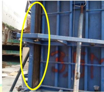
Gambar 4.27 Pelat Baja Hitam Bekisting ADMC
