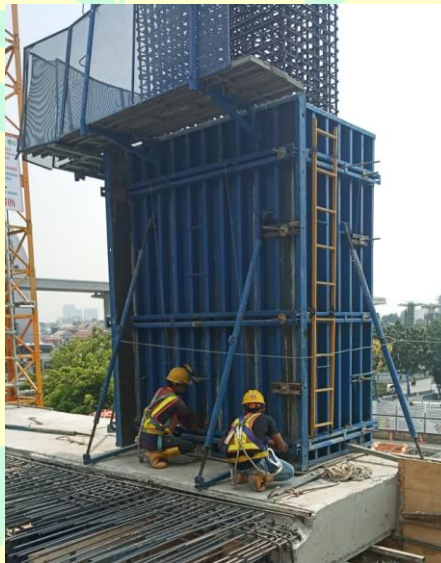
Gambar 4.23 Pengenduran Bekisting Kolom
