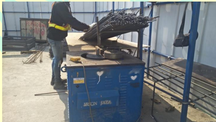
Gambar 4.9 Pembengkokkan Tulangan Kolom
