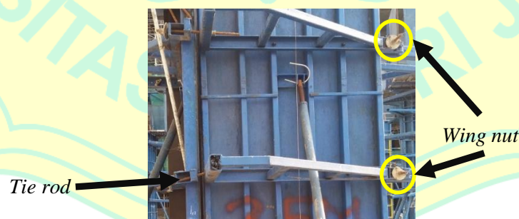
Gambar 4.28 Tie Rod dan Wing Nut
