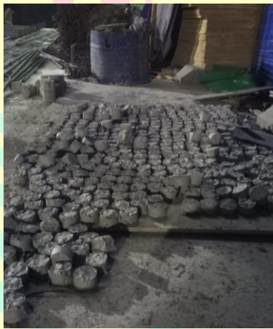
(Sumber: Dokumentasi Kelompok di Proyek Menara BRI Gatot Subroto) Gambar 4.12 Beton Decking
