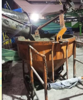
Gambar 4.20 Penuangan Beton Kedalam Bucket
