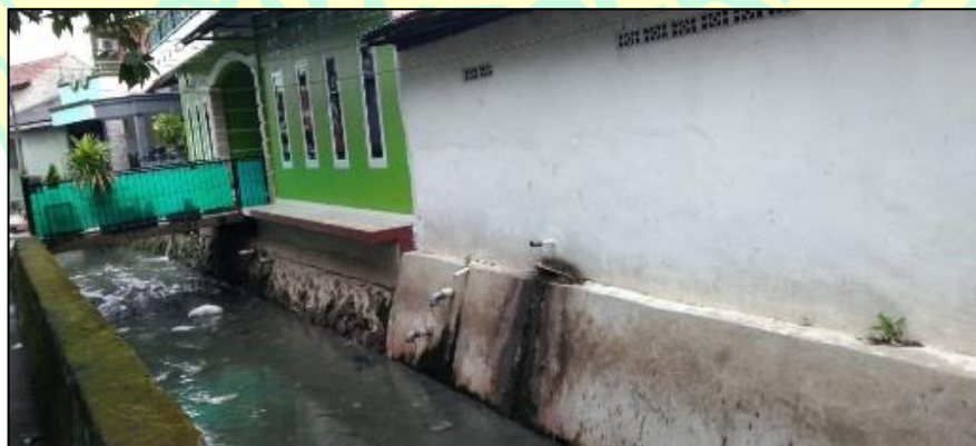
Gambar 1. 1Pipa-pipa pembuangan di kali Pasar Ciracas
