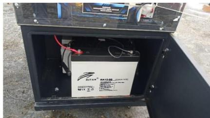
2. Jika dua *battery/accu* sudah terpasang secara parallel maka hubungkan dua kabel (+) dan (-) dari *battery/accu* pada *solar charger controller* seperti gambar berikut ini. Kabel (+) ditunjukkan dengan tanda panah merah dan untuk kabel ground (-) ditunjukkan dengan tanda panah hitam. Namun sebelum kabel (+) dipasang pada *solar charger controller*, terlebih dahulu dihubungkan pada *mcb(fuse)* untuk on/off *battery* dan keamanan alat jika suatu saat terjadi kesalahan.
