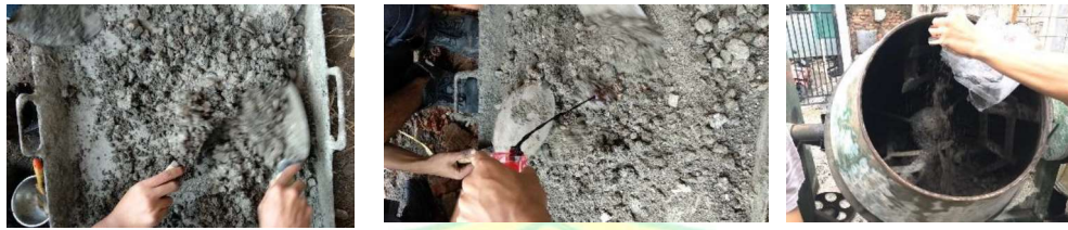
Pencampuran dan pengadukan material beton kedalam wadah & molen
