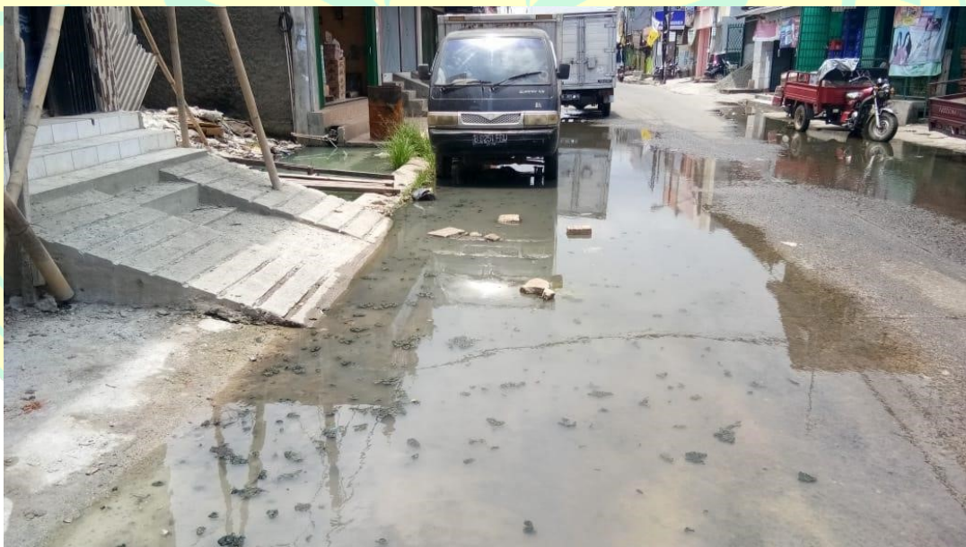
Genangan yang terjadi di jalan Perumahan
