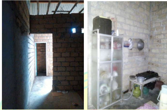
Gambar 13. Kondisi Rumah setelah Diperbaiki
