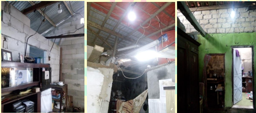
Gambar 14. Kondisi Rumah setelah Diperbaiki
