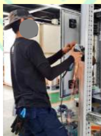
Gambar 1.3 Pekerja menggunakan gerinda tanpa memakai sarung tangan dan goggles
