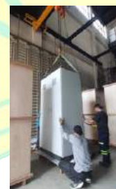
Gambar 1.5 Pekerja menggunakan over head crane tanpa memakai helm
