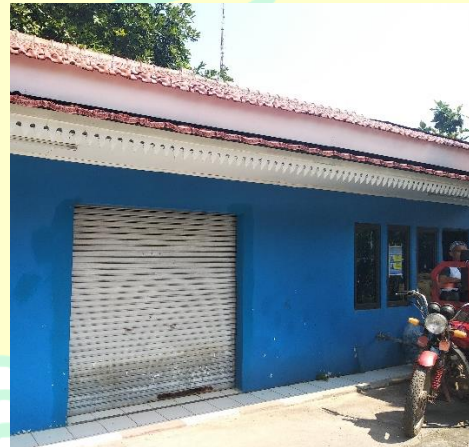
Tempat sumber air RO ( Reverse Osmosis )
