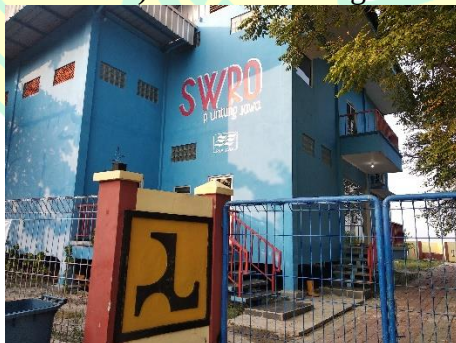
SWRO ( Sea Water Reverse Osmosis ) Potensi sumber air bersih dari penyulingan air laut
