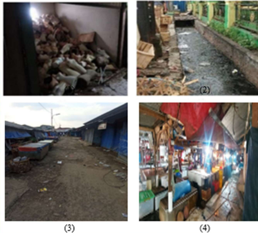
Gambar 1. 1 Kondisi Pasar Munjul, Cipayung (Sumber: Dokumentasi Pribadi, Juni 2024)
