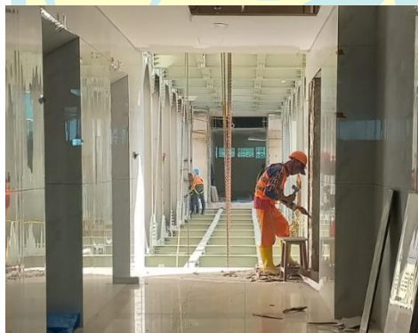
Gambar 1.5 Void area Jembatan Baja sebelum Finishing (Dokumentasi Pribadi, 2023)
