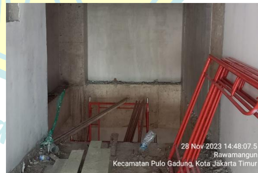
Gambar 1.4 Void area Lift Service Lantai 10 (Dokumentasi Pribadi, 2023)
