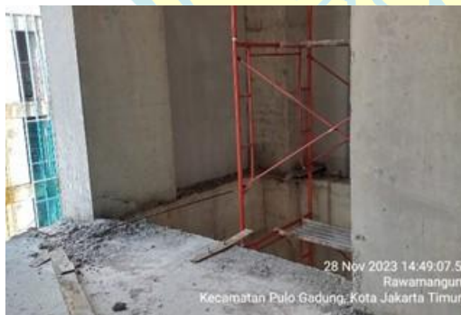
Gambar 1.3 Void area Lift Difable Lantai 10 (Dokumentasi Pribadi, 2023)
