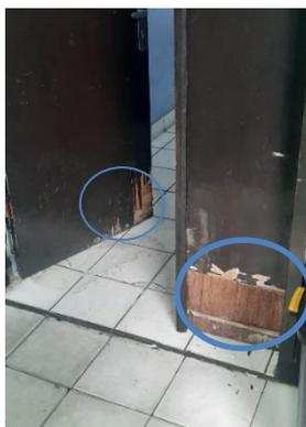
Gambar 1.3 *Defect* pada Bagian Luar Daun Pintu
