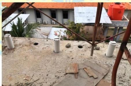
Gambar 1. 2 Jalur pipa pada pelat lantai
