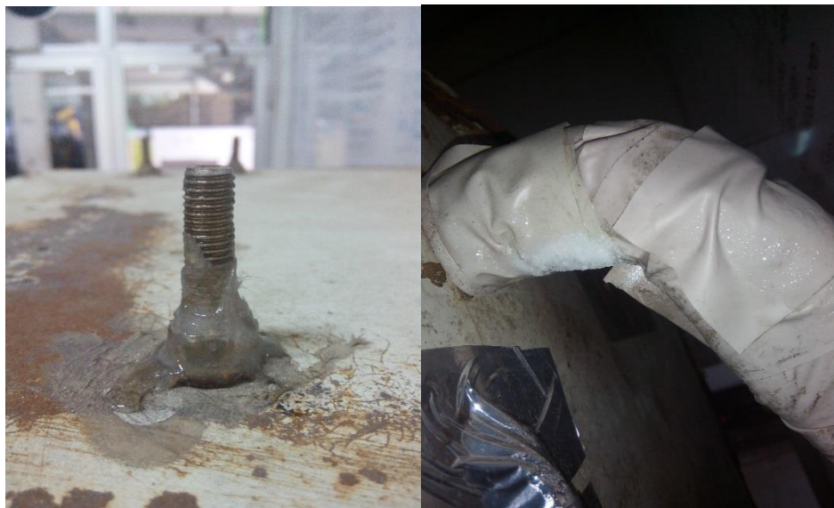
Gambar 4.63 Dudukan Evaporator dan Pipa Evaporator yang Masuk Dalam Kabin.
