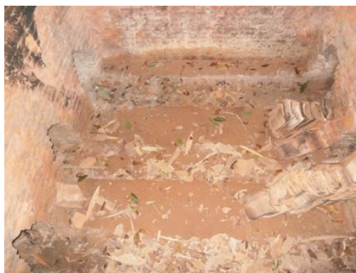
Gambar 2.15. Tampak Bagian Dalam Tungku Pembakaran Sumber : Penulis, 2018
