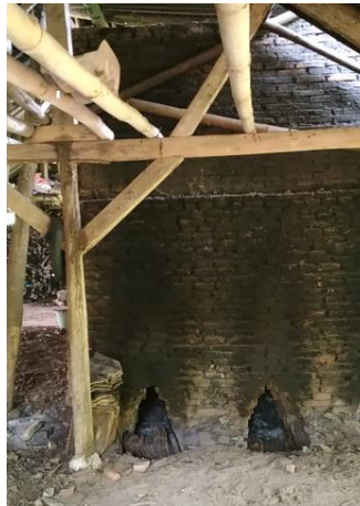
Gambar 2.12. Tampak Samping Kiri Tungku Sumber : Penulis, 2018
