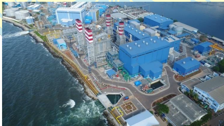
Gambar 2. 2 Area Pembangkitan di PT PLN Indonesia Power UBP Priok
